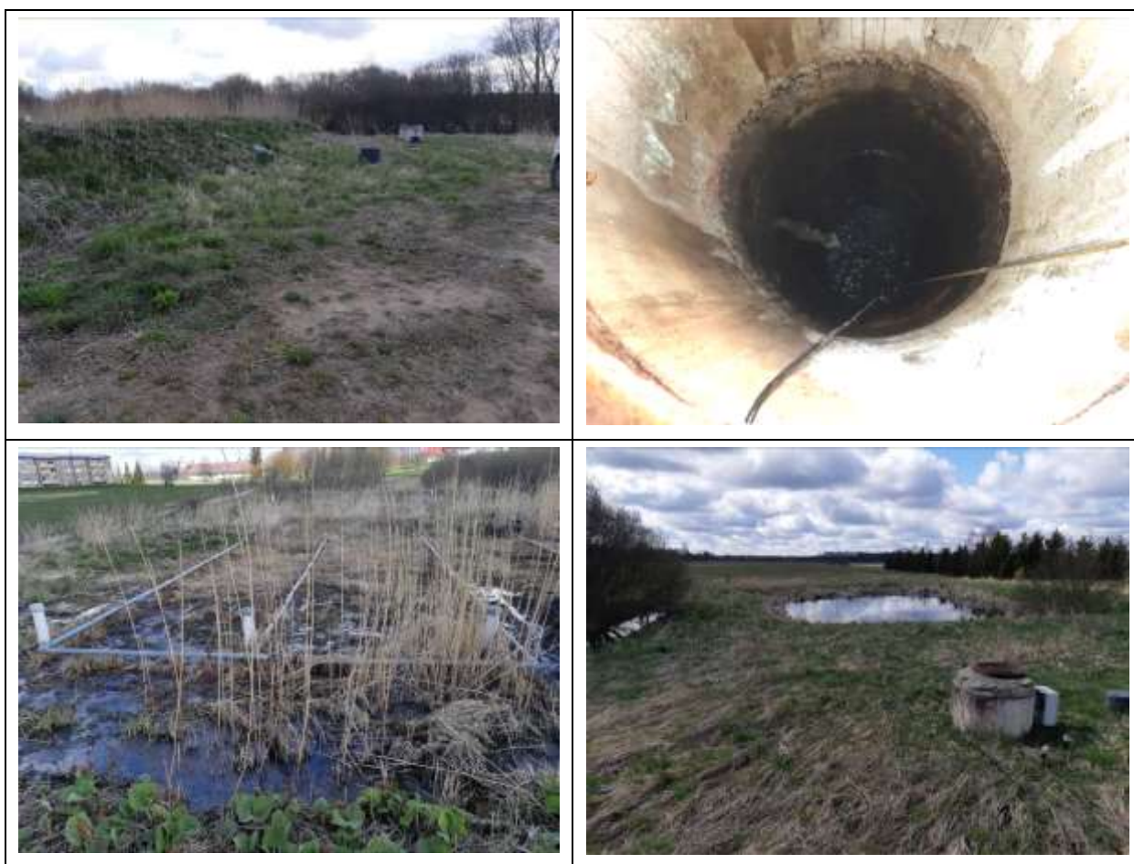
Joonis 19. Kõo küla reoveepuhasti. Fotod: OÜ Alkranel 30.04.2020.
