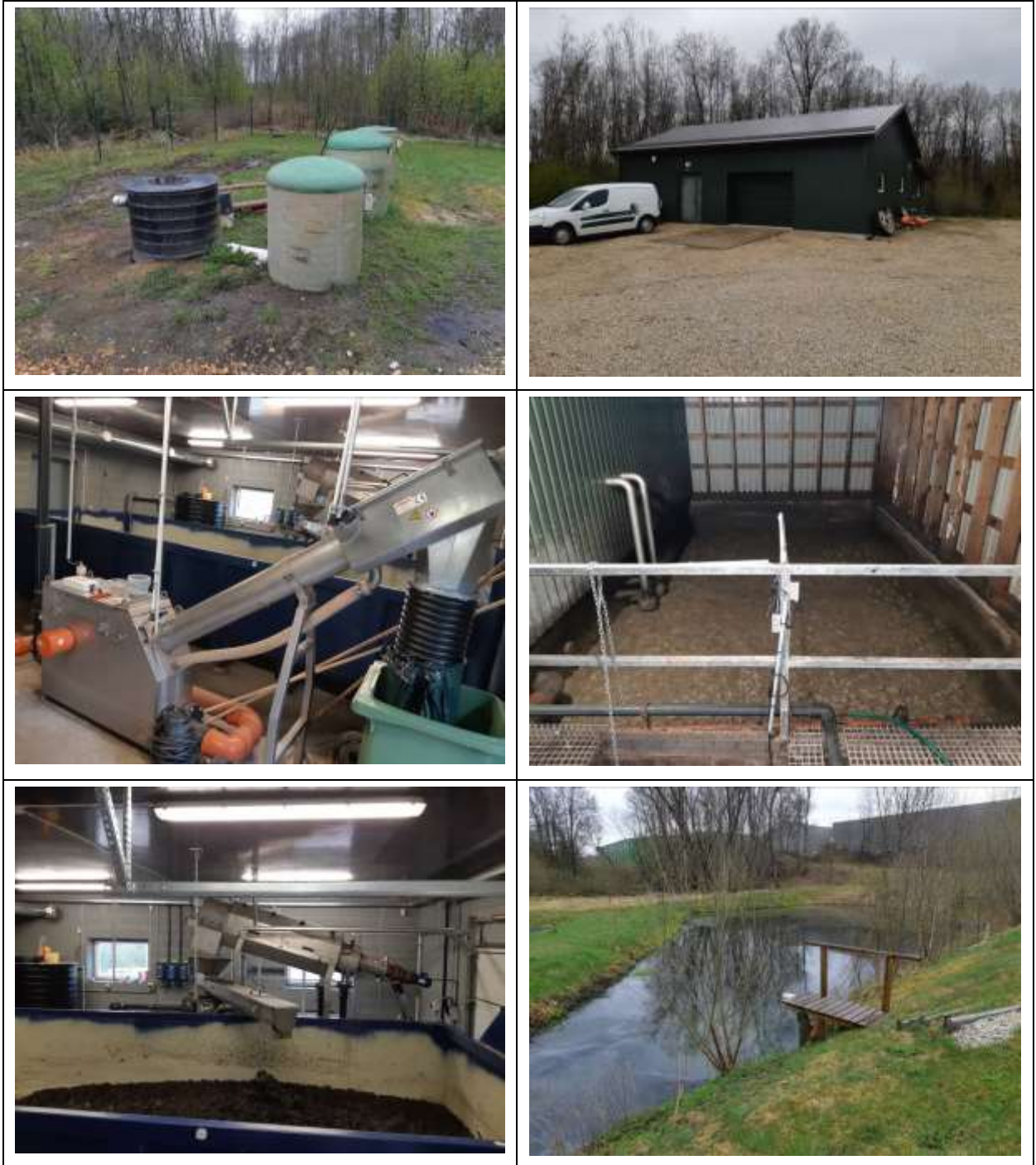
Joonis 5. Suure-Jaani linna reoveepuhasti. Fotod: OÜ Alkranel 29.04.2020.
