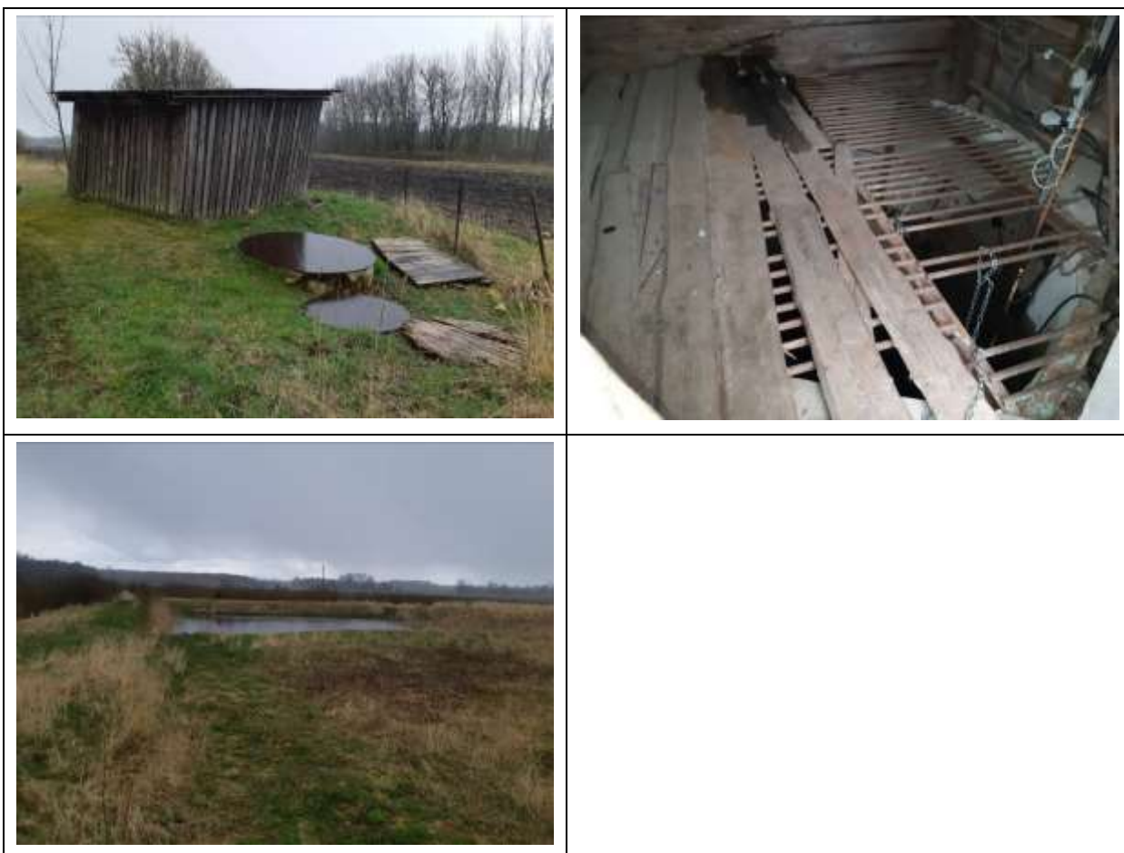
Joonis 28. Ülde küla reoveepumpla ja reoveepuhasti (biotiik). Fotod: OÜ Alkranel 29.04.2020.
