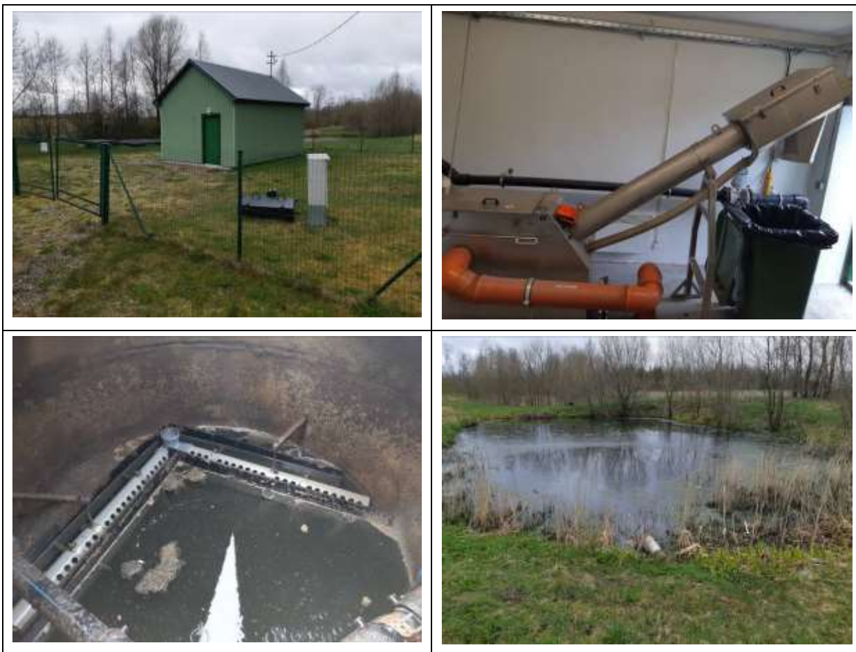
Joonis 25. Kõidama küla reoveepuhasti. Fotod: OÜ Alkranel 29.04.2020.
