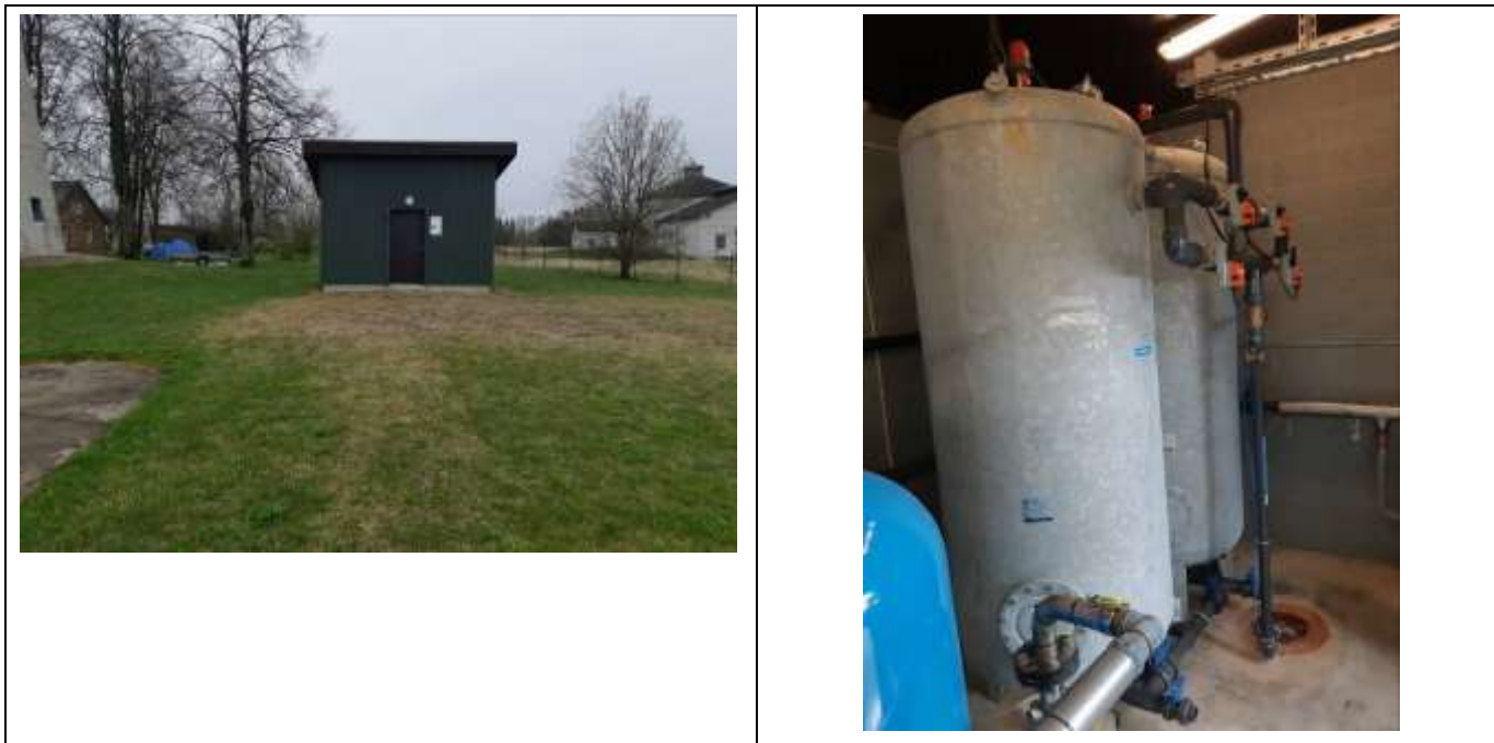
Joonis 16. Sürgavere küla puurkaev-pumpla ja veetöötlusjaam. Fotod: OÜ Alkranel 29.04.2020.
