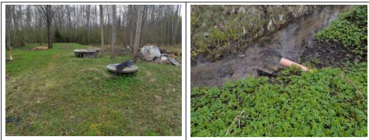
Joonis 33. Munsi küla reoveepuhasti (septik). Fotod: OÜ Alkranel 29.04.2020.
