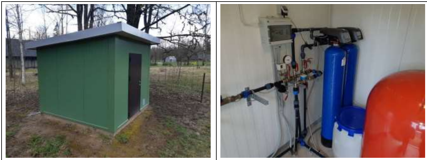
Joonis 32. Munsi puurkaev-pumpla (katastri nr 5254) ja veetötlusjaam. Fotod: OÜ Alkranel 29.04.2020.
